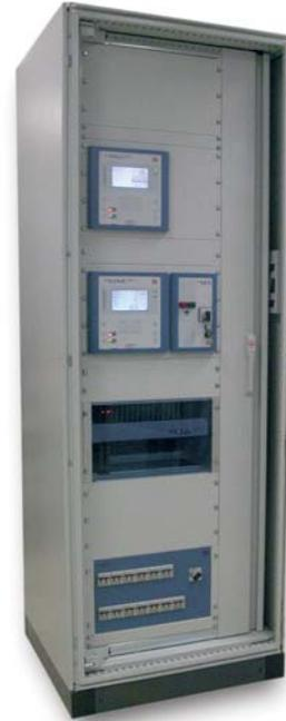
Armoire avec Unités d'Acquisition, Commande et Protection
